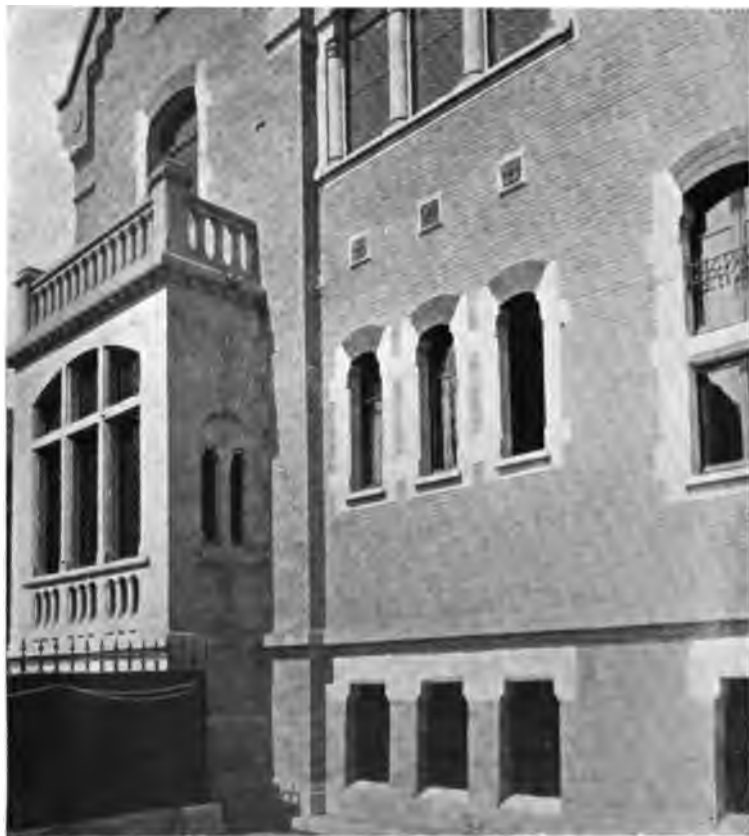
Fig. 119. — Balustrade d'appui sur la terrasse d'un hôtel particulier avenue Henri-Martin (Œuvre de L. Magne .
